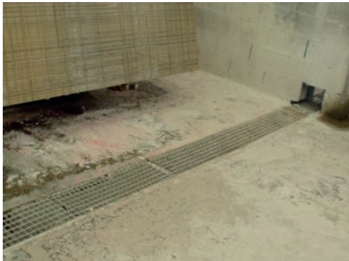
Fig. En las naves es fundamental la gestión del residuo húmedo generado, parte de la cual pasa por contar con una canalización funcionando adecuadamente.
