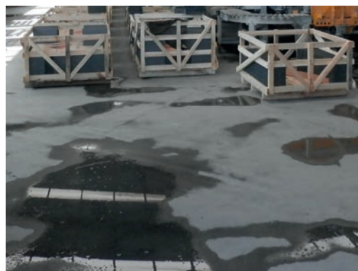
Fig. Restos de humedad en el lugar de trabajo, que evidencian una limpieza adecuada por medios húmedos.
