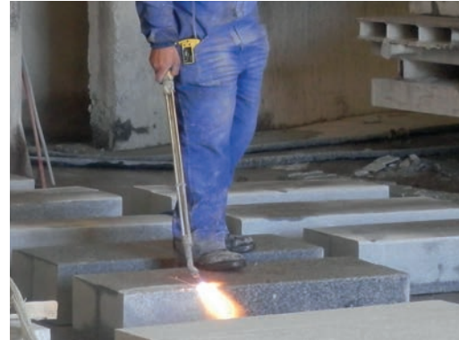
Fig. Operación de flambeado con agua, que evita el polvo en suspensión.
