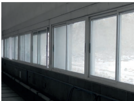
Fig. El polvo originado por los residuos que rodean la nave se pondrá en suspensión y accederá a la misma por las ventanas abiertas. Es preciso evitar este tipo de circunstancias que comprometen notablemente la eficacia del sistema de ventilación instalado.
