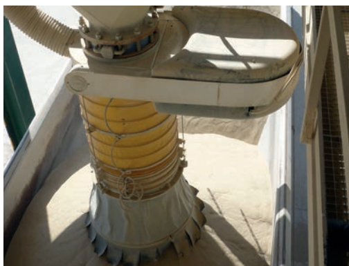
Fig. Descarga desde tolva a camión con manguera telescópica, que se optimiza contando con un plan de mantenimiento específico y una sistemática de respuesta inmediata en caso de producirse un fallo.
