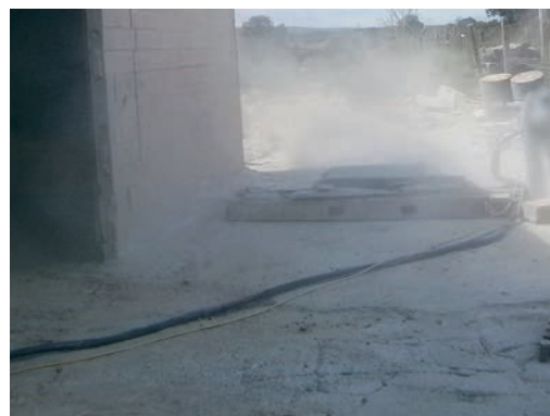
Fig. El polvo originado por los residuos que rodean la nave se pondrá en suspensión y accederá a la misma por las ventanas abiertas. Es preciso evitar este tipo de circunstancias que comprometen notablemente la eficacia del sistema de ventilación instalado.
