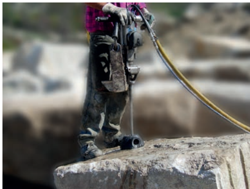
Fig. Perforación manual con uso de agua
