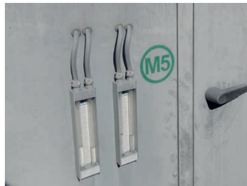
Fig. El mantenimiento del sistema incluirá la periodicidad de revisión del indicador de rendimiento de filtrado, permitiendo organizar el cambio de filtro cuando sea preciso, sin añadir demoras innecesarias que harían funcionar la instalación sin la deseable eficacia.
