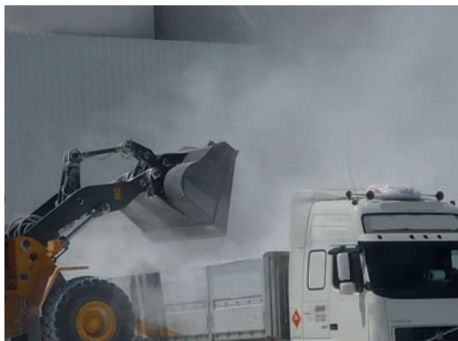
Fig. Las operaciones de carga deben realizarse minimizando la puesta en suspensión de polvo y sobre todo evitando que el mismo afecte a otras partes de la instalación frecuentadas por personal.
