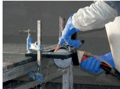
Fig. Detalle de aplicación de agua a tareas de acabado
