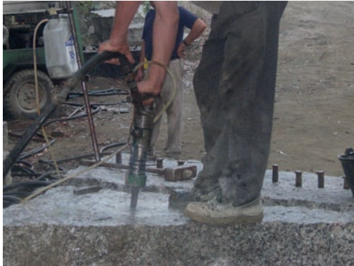
Fig. Corte de bloque con herramienta manual dotada de agua.
